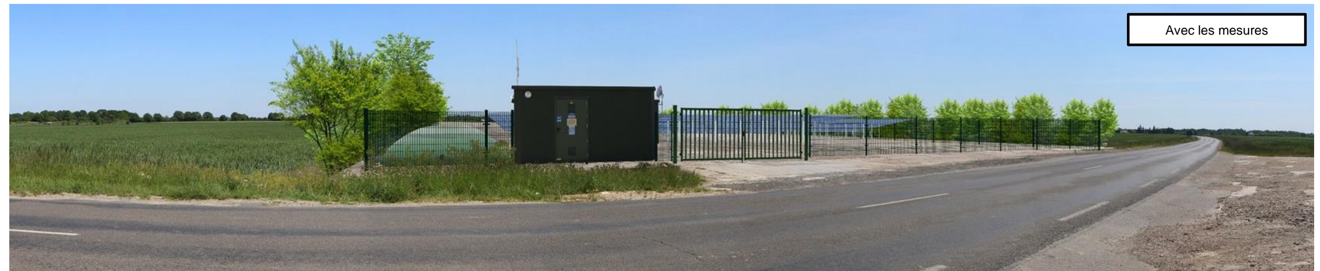
Figure 28 : Photomontage C – Depuis la D53, aux abords immédiats du futur parc, par le sud-est – Etat projeté (© ATER Environnement 2021)
