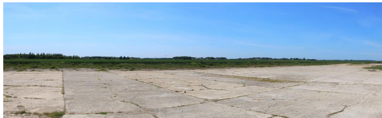
Figure 3 : Vue sur la zone d'implantation potentielle (source : ATER Environnement, 2021)
