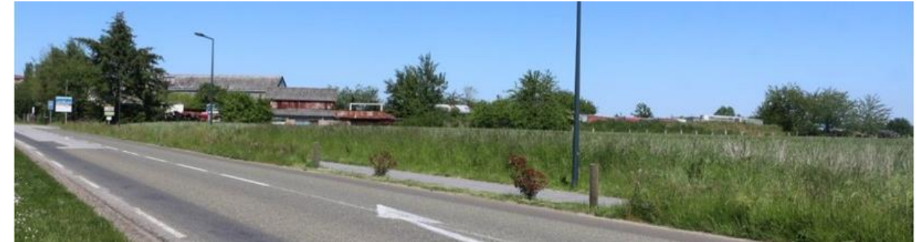
Figure 42 : RD 53 en entrée sud de la commune de Saint-André-de-l'Eure (source : ATER Environnement, 2021)
